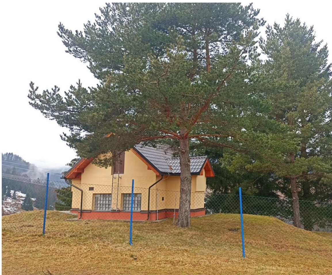
Obr. Vodárenský objekt –Vodojem Liptovská Osada 2x100m 3
