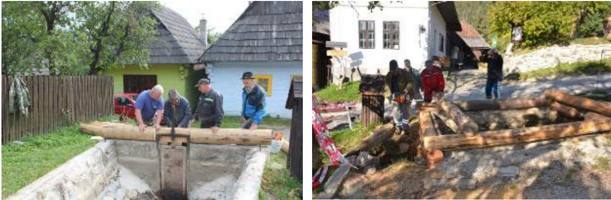
Obr. 51 Oprava výdrevy požiarnych nádrží vo Vlkolínci v roku 2020 (vľavo) a v roku 2021 (vpravo) (foto: Mesto Ružomberok)
