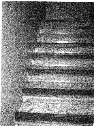
schodisko do II. NP
