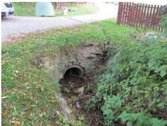
Obr. č. 2: Prečistenie priepustov (foto: P. Caban, jeseň 2021)
