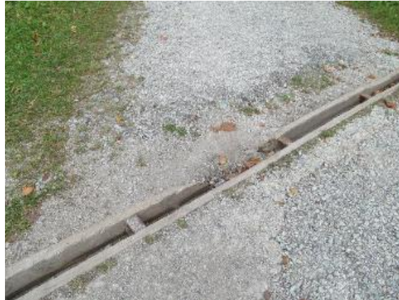
Obr. č. 3: Oprava drevených odrážok na odvádzanie zrážkovej vody (foto: P. Caban, jeseň 2021)
