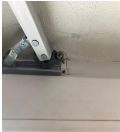
**6) Vyriešenie problémov s oknami, ktoré sa nachádzajú na 1. nadzemnom podlaží** - osadené okná sa nedajú otvárať, čo znemožňuje vyčistenie okien. Na oknách sú taktiež poškodené hliníkové žalúzie, ako aj ich mechanizmus.
