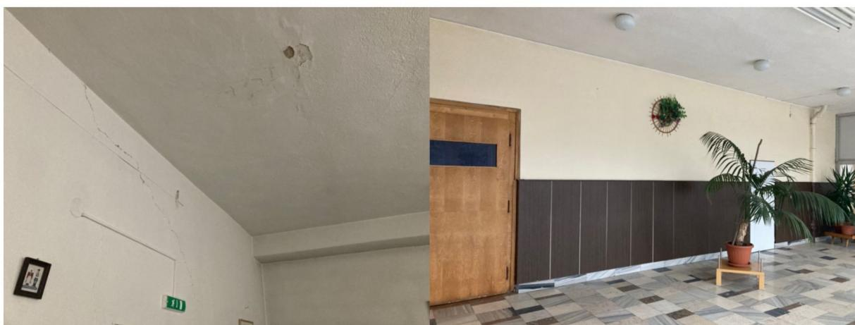
**6) Rekonštrukcia odkvapových rozvodov** - odkvapové rúry resp. zvody sú umiestnené v stenách KD (nie po vonkajšom plášti), čo spôsobuje zatekanie a degradáciu muriva resp. interiérových stien.
