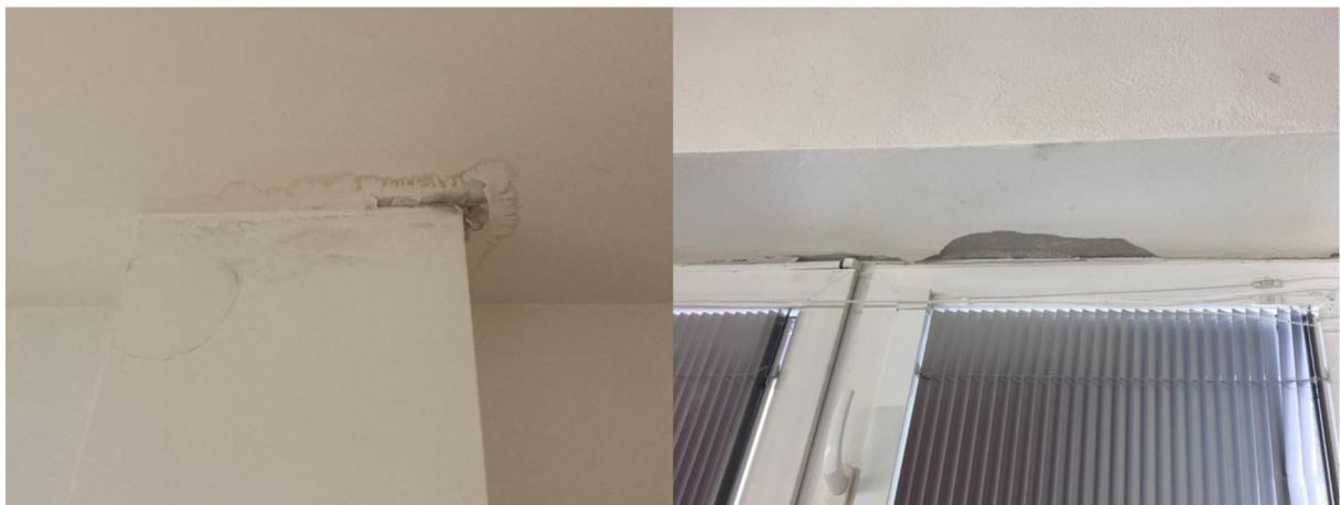
**5) Oprava mechanického systému na otváranie okien** – systém je v mnohých prípadoch vytrhnutý z rámu okien. Okná sa nedajú otvárať.
